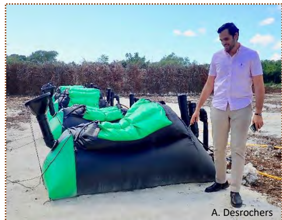
Projet pilote de biogaz à Punta Cana, en partenariat avec l'Université APEC
