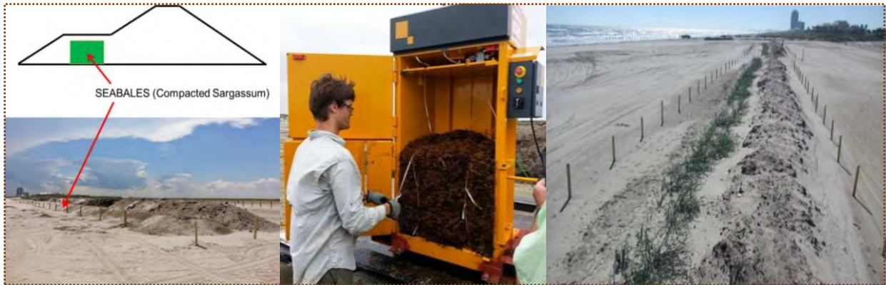
Projet de balles de sargasses pélagiques « Seabale » pour la restauration des dunes de Galveston Island, conduit par l'Université A&M du Texas. Source : Figlus et al. (2015).
