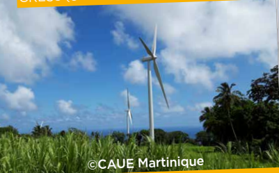
GRESS (Grand Rivière Eolien Stockage Service)
